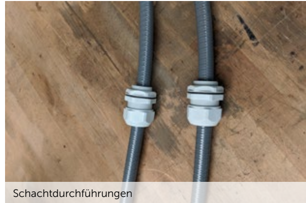
Auslass des Schaltschlauchs vom Körper der Gegenstromanlage über das Reduzierstück zum Schutzschlauch
