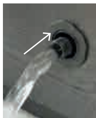
4. Zatlačením ventilu dovnitř se průtok vody zvýší
